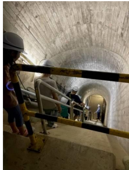
写真9 バックヤードツアー（四十四田ダム監査廊）
