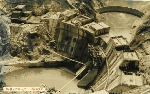
写真4 湯田ダム堤体工事写真(1963年5月撮影)
